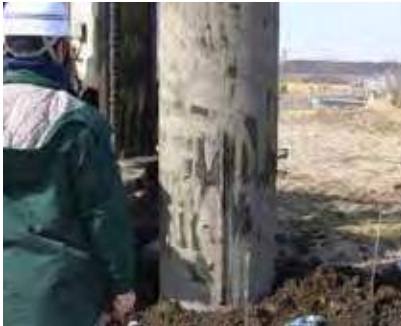
ケーシング引抜き
