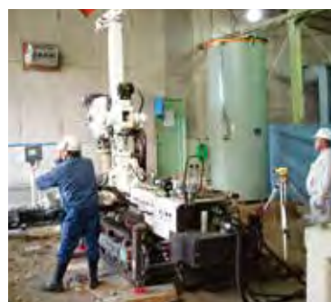
屋内施工状況
