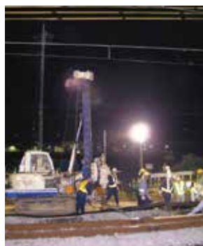
夜間工事状況
