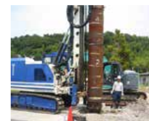
ケーシング建込み
