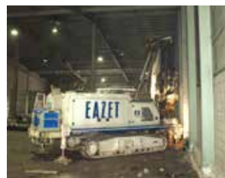
屋内施工状況
