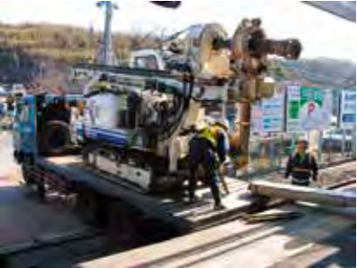
搬入トラックからホームへの搬入
