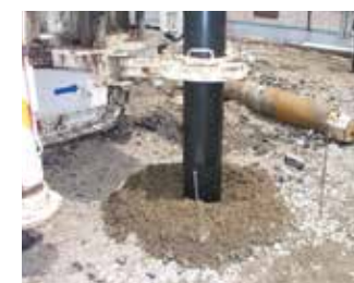
無排土施工状況
