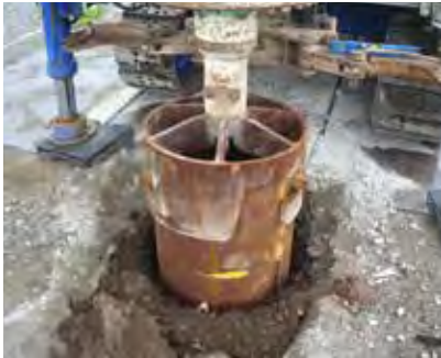
ケーシング埋設完了
