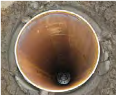
ケーシング埋設完了時内部
