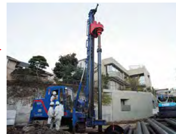
8. 中杭以降の杭を打設
