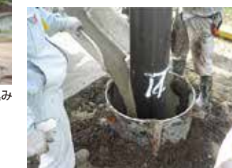
杭打設後遮水材投入
