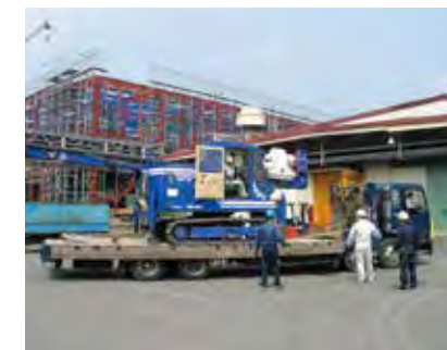
1. 施工機械搬入
