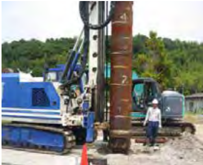
ケーシング建込み
