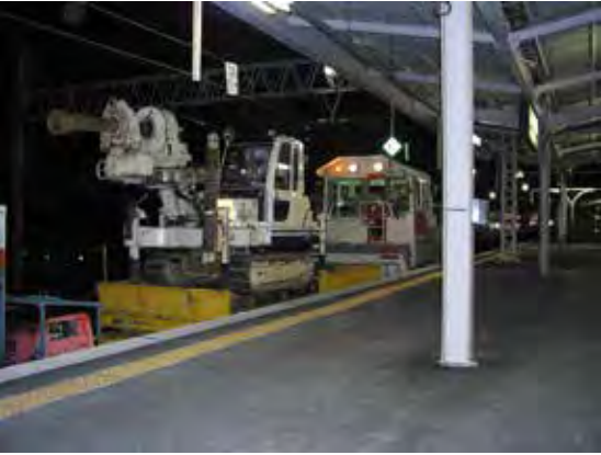
搬入用列車を利用した搬入
