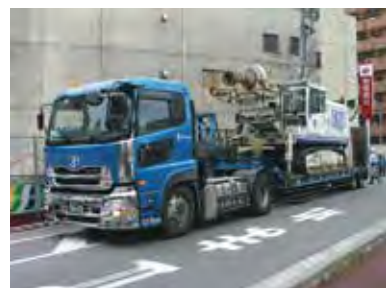
施工機械移送
