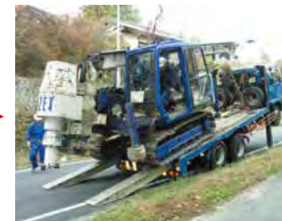
2. 施工機械降ろし
