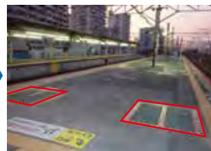
J-DAIA工法(施工箇所を塞いだ例)
