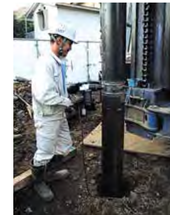
NCCジョイントによる接続状況
