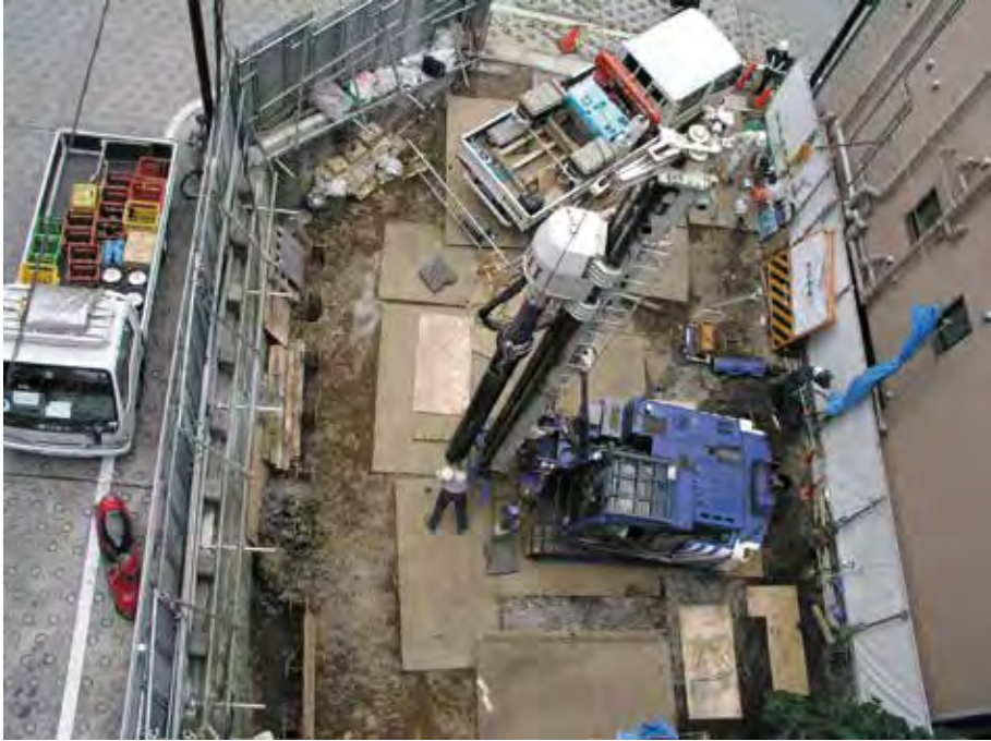
上方から見た施工現場の状況
