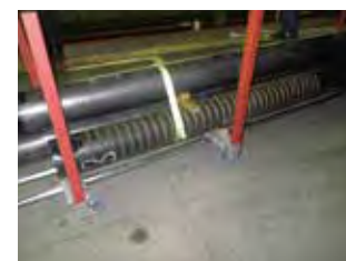
溶接ビードを施した上杭を施工
