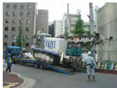
施工機械降ろし
