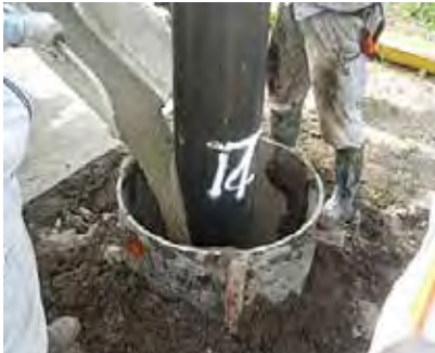
杭打設後遮水材投入
